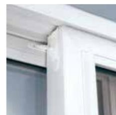
Les butées d'aération du châssis permettent à l'air frais d'entrer.
